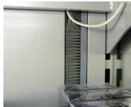
Als Kabeldurchführung im Ladenbau As a cable feedthrough in shopfitting Comme traversée de câble dans l'aménagement de magasins
